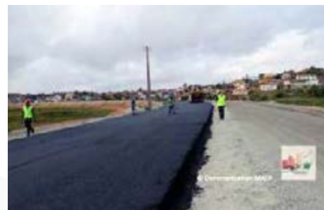
Les travaux de la Rocade nord-est seront bouclés d'ici peu.
